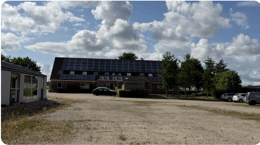
De woonboerderij, met zonnepanelen over het volledige dakvlak
